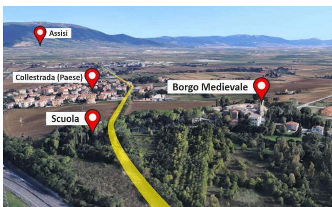
Viabilità storica, strada Ospedalone San Francesco
